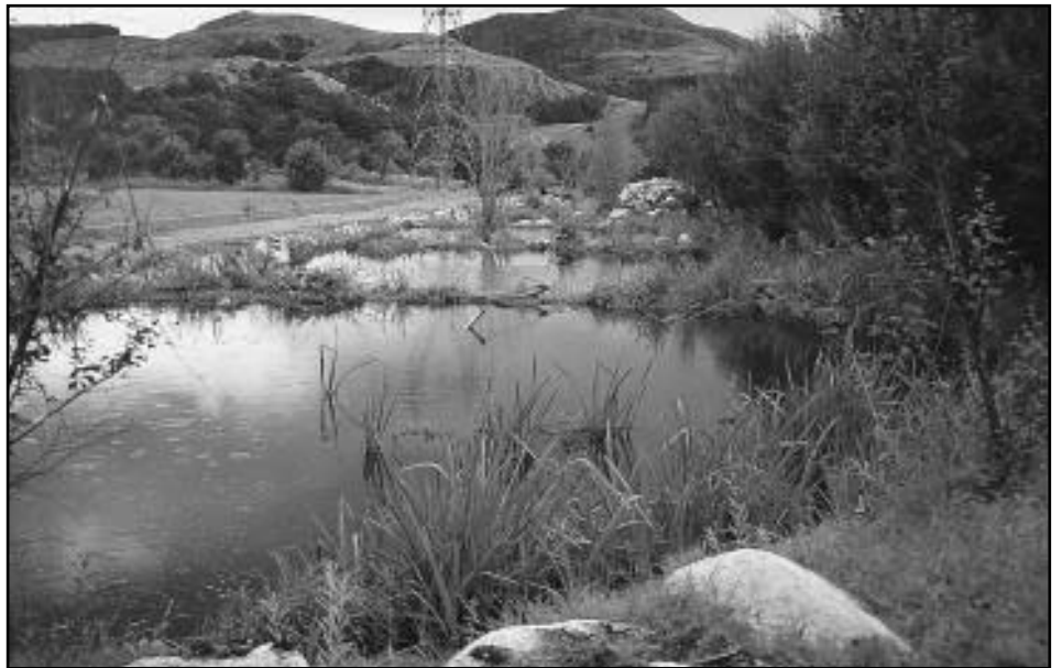
Øvre del av renseparken hos Tore Kverneland ved Orrevassdraget på Jæren. Renseparken har syv fangdammer som til sammen dekker et areal på 940 m 2 .
